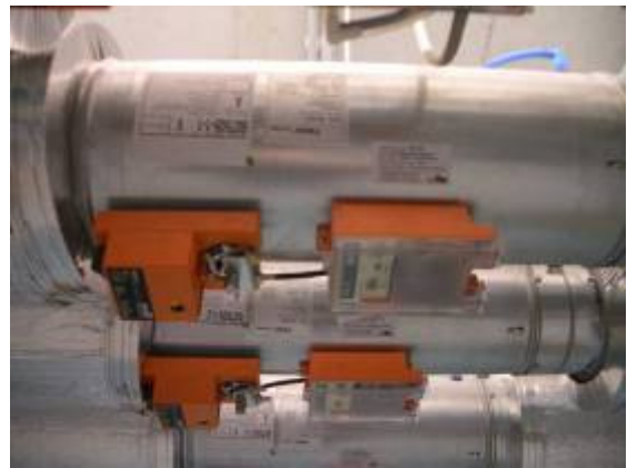
Abbildung 9.49 a und b: Automatische Luftmengenregelung über Mischgasfühler
