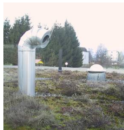
Abbildung 9.39: Fortluftführung über Dach
