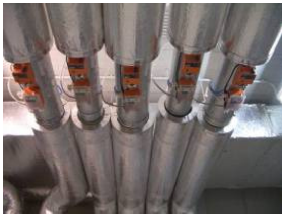
Abbildung 9.49 a und b: Automatische Luftmengenregelung über Mischgasfühler
