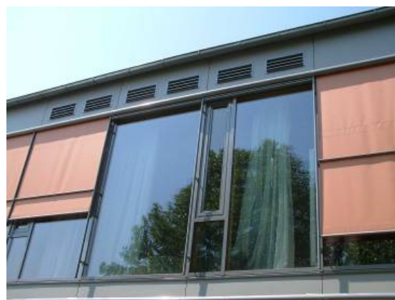
Abbildung 9.28: Ansaugung über Gitter in der Drenpelwand des Spitzbodens
