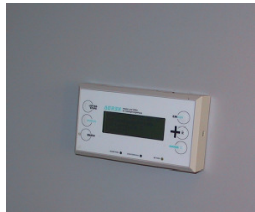
Abbildung 9.47 a und b: Steuerungsgeräte für dezentrale Lüftungsgeräte
