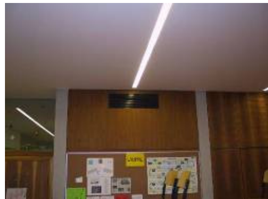
Abbildung 9.59 a und b: Zu gering bzw. sehr knapp bemessene Überströmbereiche
