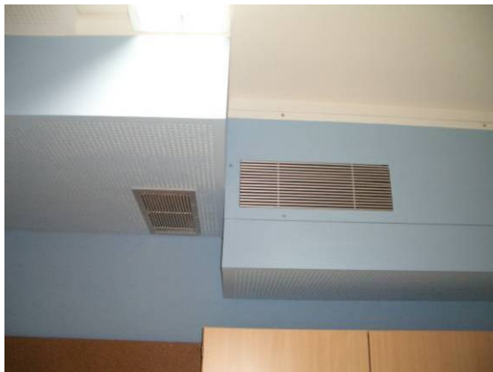
Abbildung 9.8: Luftführung Zu- und Abluft
