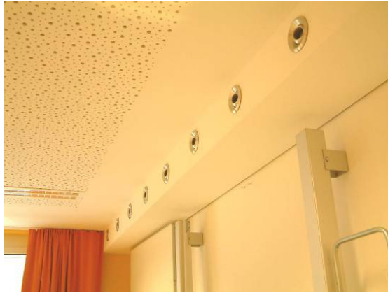
Abbildung 9.23: Düsenaufstände etwas zu gering – Abhilfe „Auffächerung“ der Strahlen
