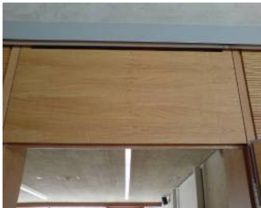
Abbildung 9.59 a und b: Zu gering bzw. sehr knapp bemessene Überströmbereiche
