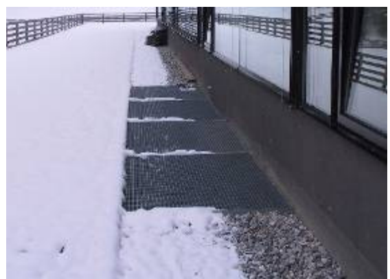
Abbildung 9.31 a und b: Ansaugsituation durch Kellerschacht: li Blick in den Schacht, re. Außenansicht: Gefahr der Ansaugung von bodennahen Gasen (z.B. Radon). Schneefreiheit durch Fassaden- nähe und Schachtgitter gegeben
