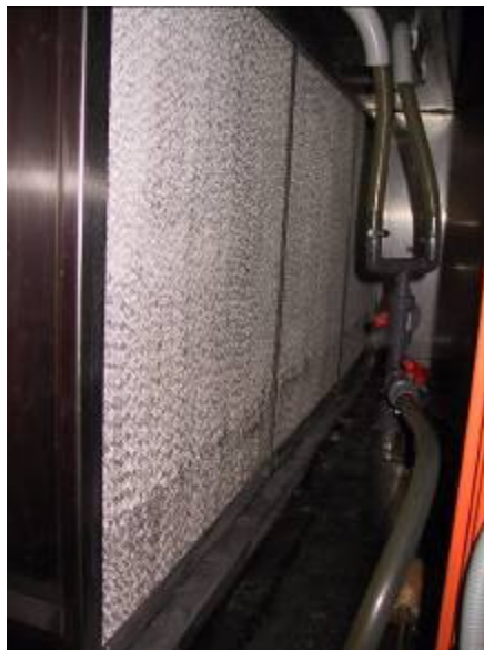
Abbildung 9.53: Bild des sehr gut gewarteten Kontaktbefeuchters
