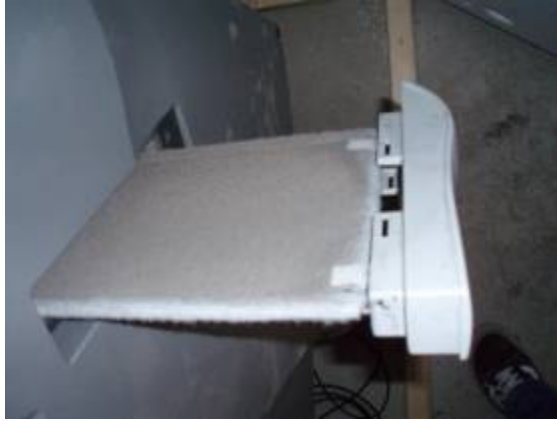
Abbildung 9.43: Einfache Filtermatte (G4) einer dezentralen Anlage
