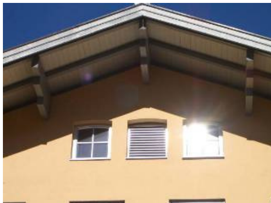
Abbildung 9.25: Ein früheres Fenster wurde bei dieser Sanierung zur Ansaugung der zentralen Anlage umfunktioniert
