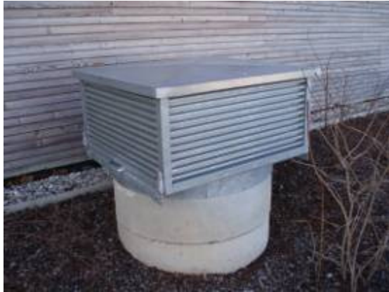
Abbildung 9.29: Zu geringe Ansaughöhe
