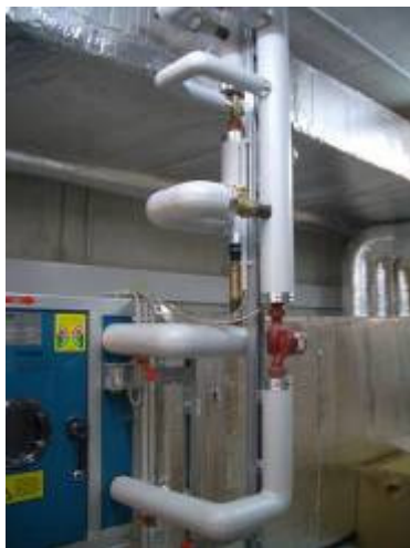
Abbildung 9.52: Nacherwärmung über ein wassergeführtes System
