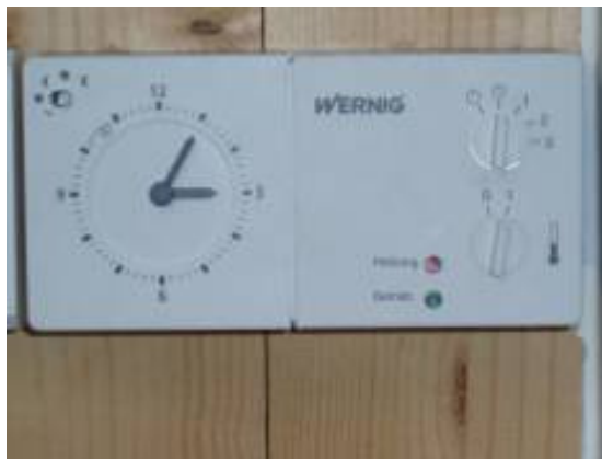
Abbildung 9.47 a und b: Steuerungsgeräte für dezentrale Lüftungsgeräte
