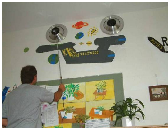
Abbildung 9.24: Überdimensionierung der Kugeldüsen (DM 150, Austrittsgeschw. 3,5 und 3,9 m/s)
