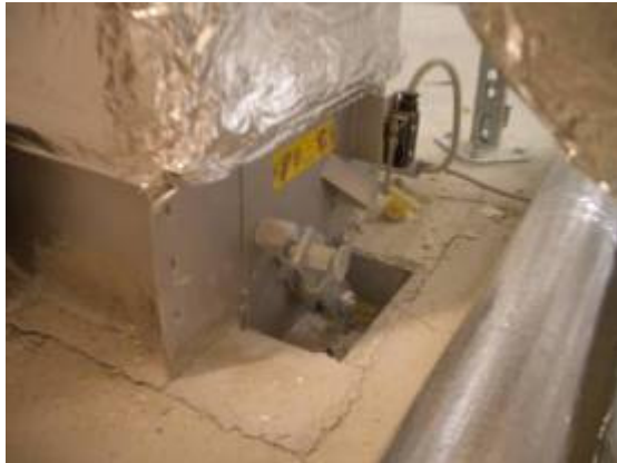
Abbildung 9.58: Brandschutzklappe mit Kontaktschalter für GLT
