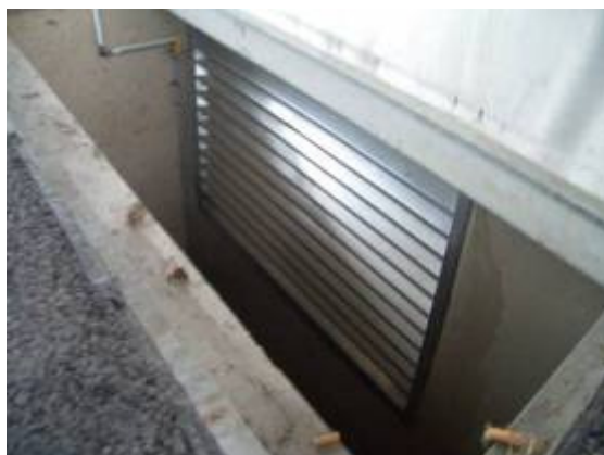
Abbildung 9.38: Fortluft über einen Kellerschacht
